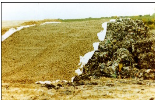
photo 7 : la protection définitive des balles, une géomembrane en pente, des graviers pour drainer les eaux de pluie.
