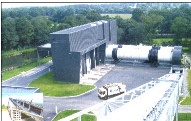
Photo 2. L'usine de compostage de Launay- Lantic ,Côtes d'Armor : les deux tubes de préfermentation et le tapis à bande de 80 m.
